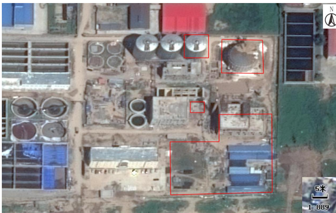
图 2.3-2 河北银发华鼎环保科技有限公司谷歌影像图（2013.8） （固体发酵罐、抗生素菌渣储池、污泥脱水房等基本建成）
