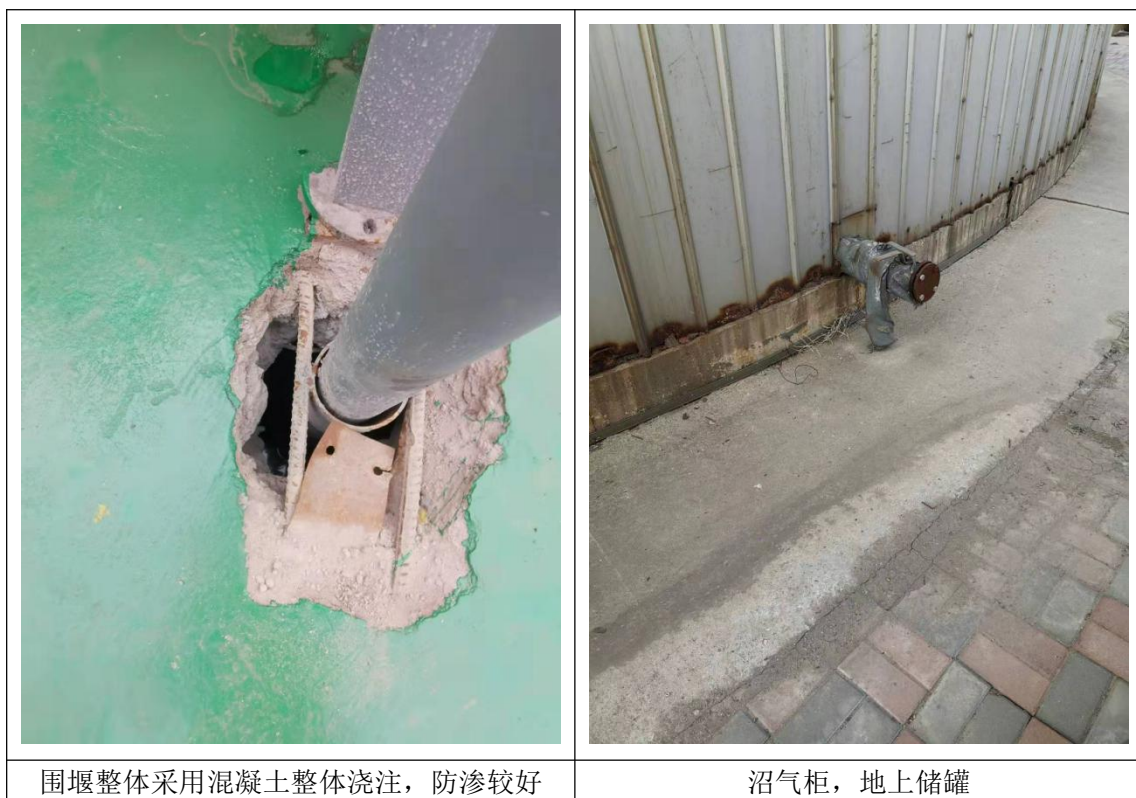
图 4.1-1 河北银发华鼎环保科技有限公司现场踏勘记录
