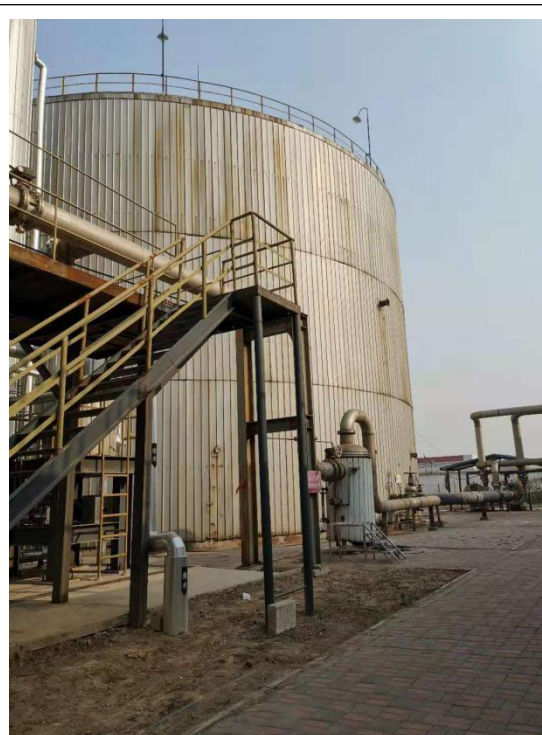
沼气柜，地上储罐，无明显污染痕迹，闲置
